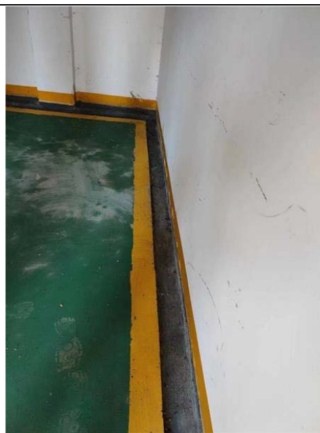
厂区危险废物暂存间地沟
