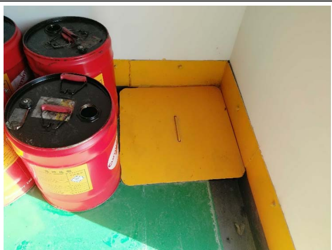
矿区危险废物暂存间地沟及收集池
