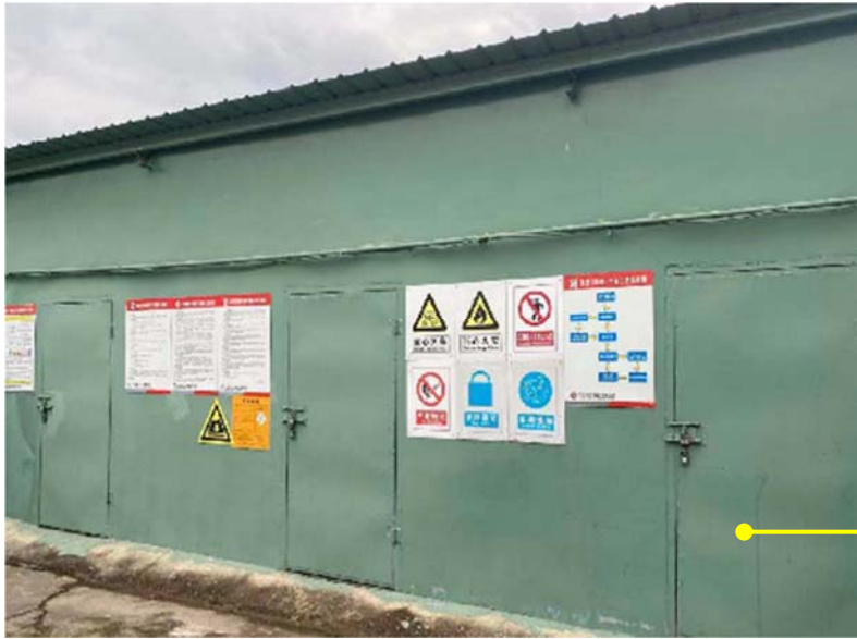
石灰石矿区危险废物暂存间 5#6#7#
