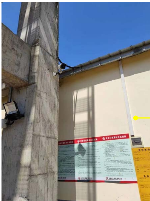
水泥厂区危险废物暂存间 3#
