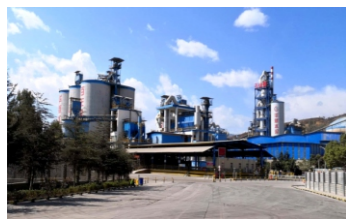
整洁亮丽的工厂厂区 A tidy, shiny plant
